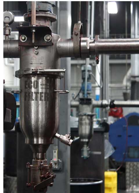
Figura 1: O filtro pode ser instalado em tubulações existentes para remover partículas metálicas contaminantes
