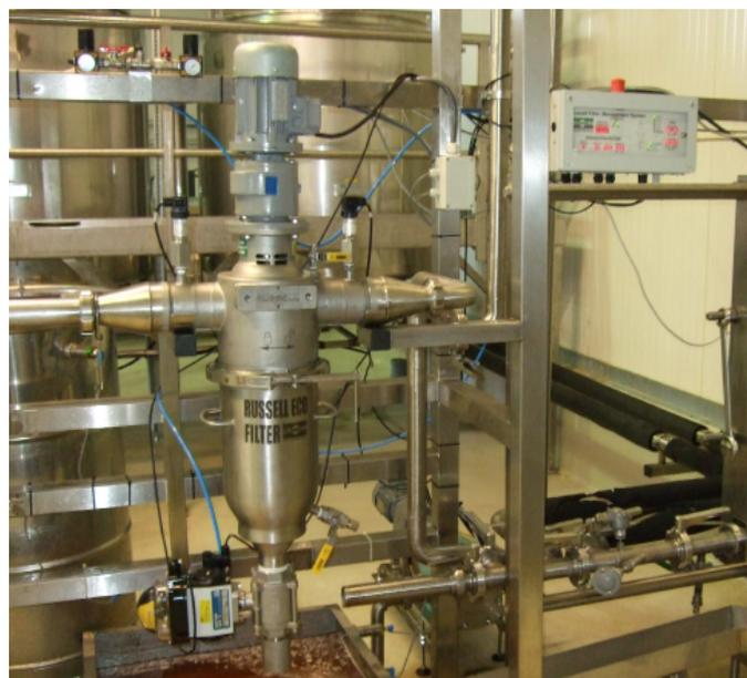
**Figura 1:** O Self Cleaning Russell Eco Filter® instalado em uma linha de processamento de mel
