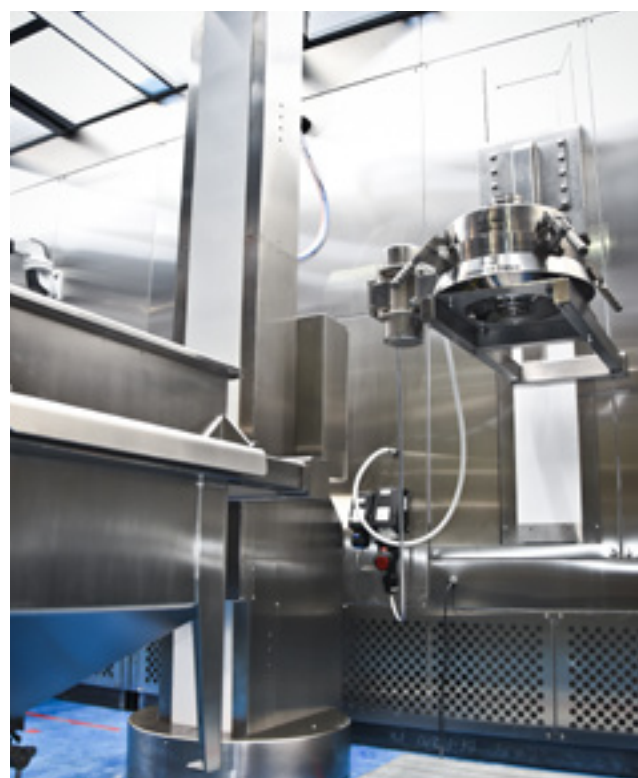
Figura 1. Instalação da Russell Compact Sieve® ao lado da plataforma de elevação
