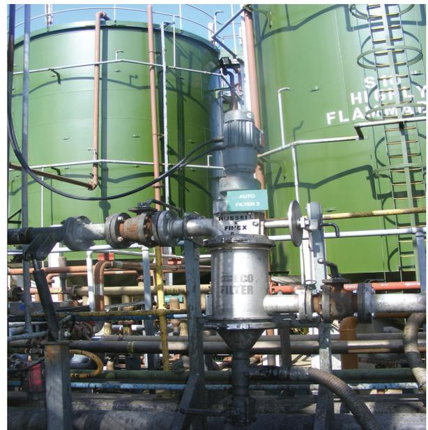
**Abbildung 1.** Einer der Russell Eco Filter®, der bei Veolia installiert wurde
