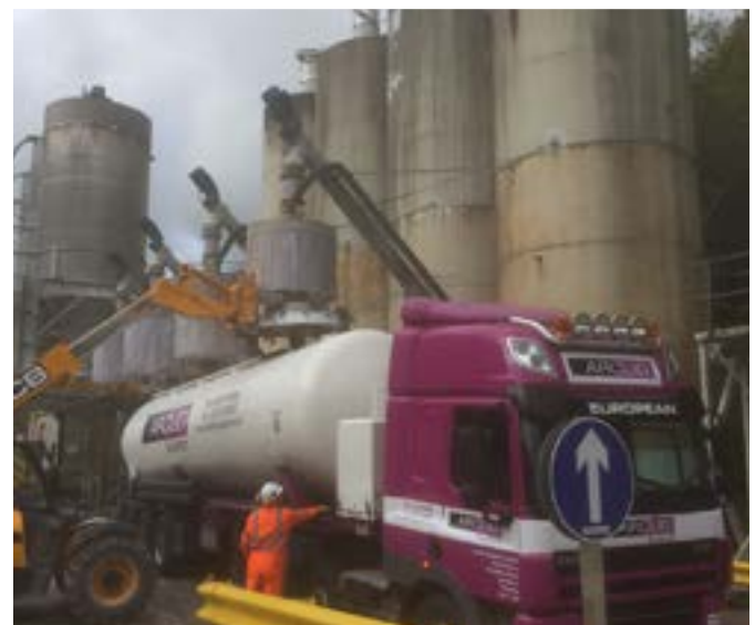
Abbildung 1. Das Russell Compact Sieve® im Einsatz zur Kontrollsiebung von Marmorpulver während der Beladung von Lastwagen
