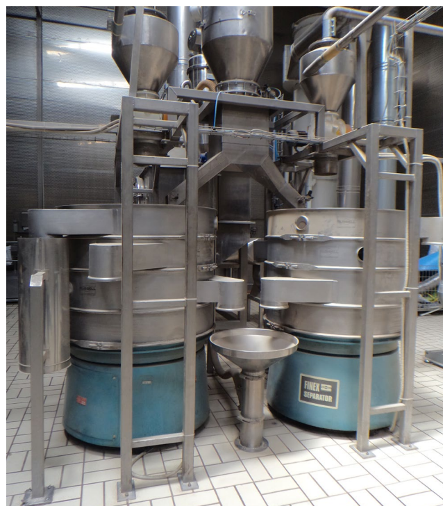
Figura 1. Instalación de dos unidades Finex Separator™ en la línea de producción de semillas de sésamo de Haitoglou Bros SA
