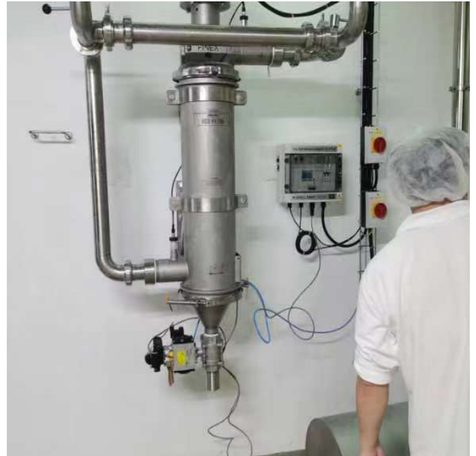
Imagen 2: La instalación del Self-Cleaning Russell Eco Filter®
