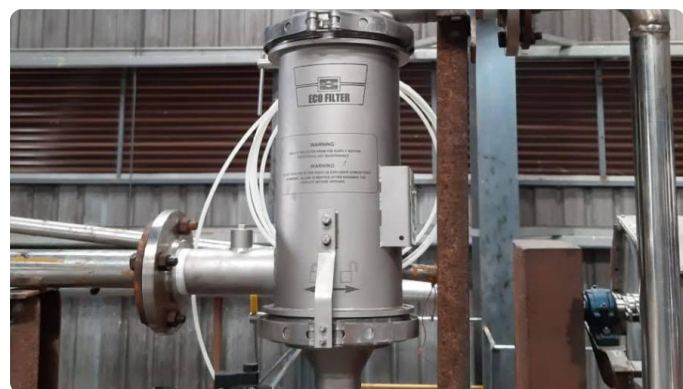
Instalación del Self-Cleaning Russell Eco Filter®
