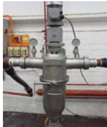
Afbeelding 1. Self-Cleaning Russell Eco Filter® geïnstalleerd bij Angus Fire
