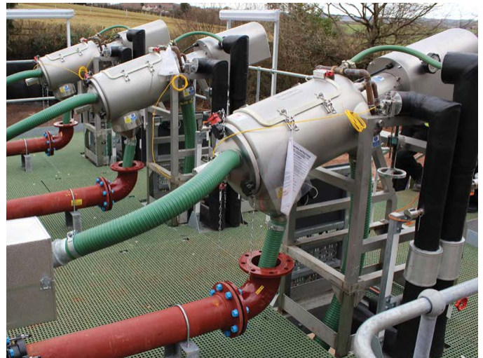
Figure 1. Der Liquid Solid Separator™ installiert in einer Wasseraufbereitungsanlage
