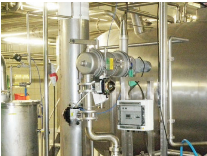
Photo 2: Le Russell Filter Management System™ installé sur un Self-Cleaning Russell Eco Filter® (à l'horizontale)
