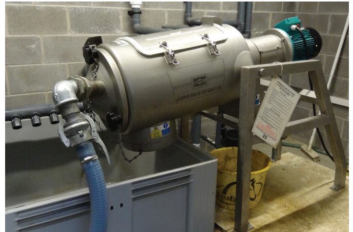
Figure 1: Le Russell Liquid Solid Separator™ installé dans un centre de rééducation pour chevaux afin de nettoyer les eaux de lavage de manière efficace
