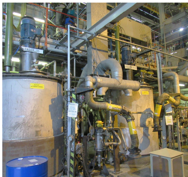
Image 2. Le Self-Cleaning Russell Eco Filter® de Lucite est utilisé pour éliminer les résidus de leur résine adhésive utilisée pour les pansements chirurgicaux
