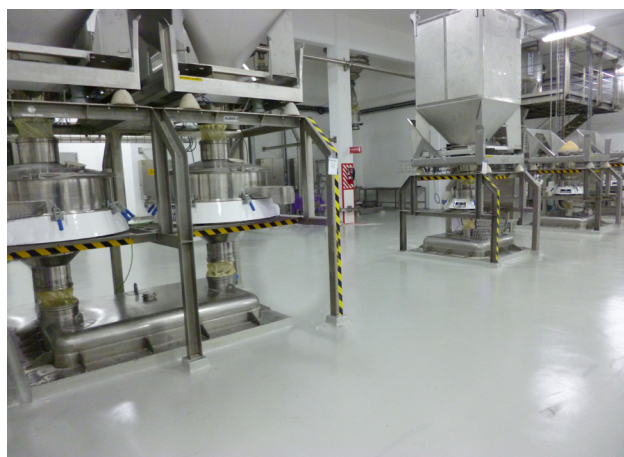
Zdjęcie 1 - Przesiewacz wibracyjny Russell Compact Sieve® zainstalowany w nowym zakładzie do przesiewania mleka w proszku w Chile
