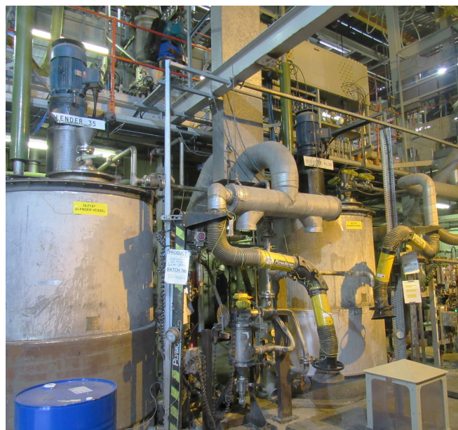
Ilustracja 2. Self-Cleaning Russell Eco Filter® zainstalowany w zakładzie Lucite jest używany w celu usunięcia skumulowanych cząstek żywicy adhezyjnej, stosowanej do produkcji plastrów chirurgicznych
